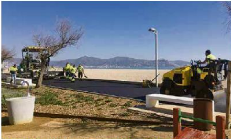
VORERA DE LA PLATJA. Els treballs se centren ara arran de sorra
