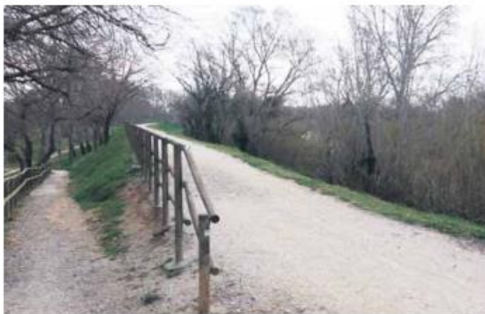
La via verda del terraplè de Castelló a Empuriabrava tindrà enllumenat ■ ACE
