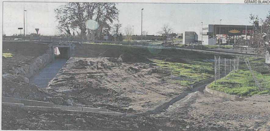
Una part del carril ciclista de la rotonda de Sant Pere ja està construïda, i ara falten 300 metres més.
