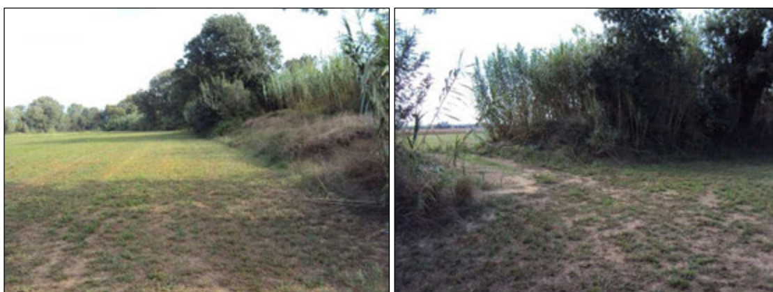
Vista de la secció de la mota o dic de terres existent en el marge dret del riu La Mugueta
