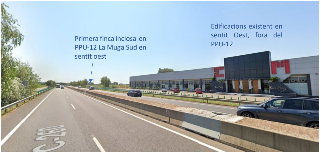
Vista a 700m abans de l'arribada a la rotonda de Fortià
