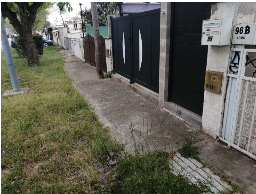
Rampes autoconstruïdes pels veïns a enderrocar
