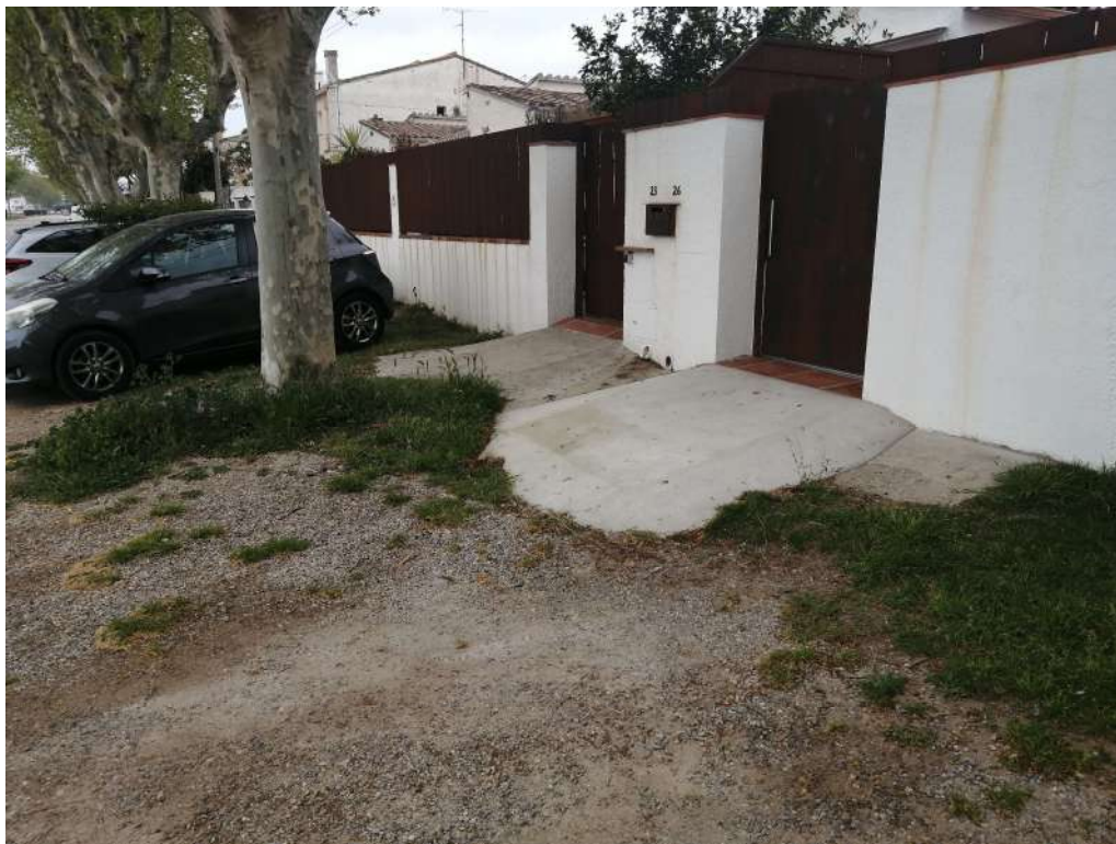
Rampes autoconstruïdes pels veïns a enderrocar
