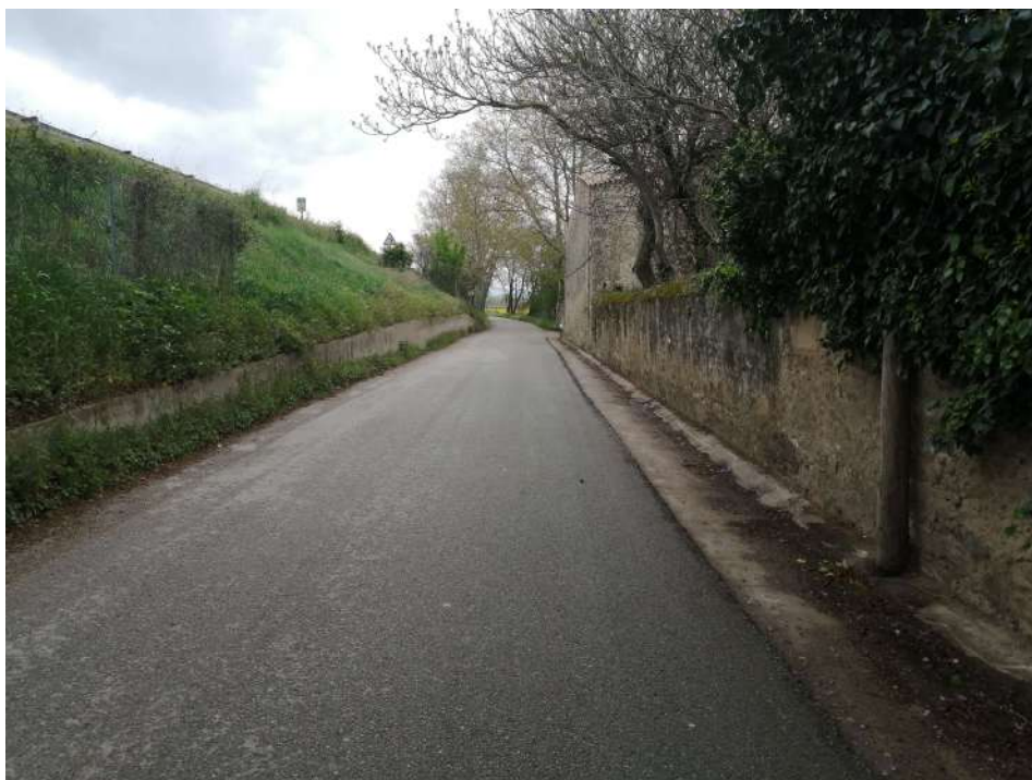
Calçada existent, on conviuran el carril bici i el carril de tràfic rodat. El carril bici s'ampliarà cap a la masia.
