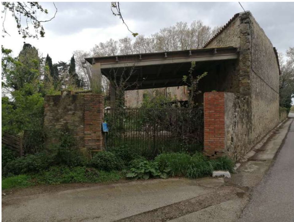
Entrada existent a la masia annexa al Tram 2 del carril bici, a mantenir i senyalitzar
