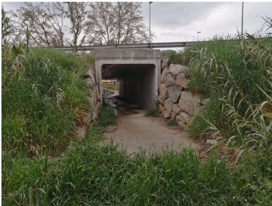
Punt de connexió amb la urbanització de Castelló Nou, a través del pas soterrani existent
