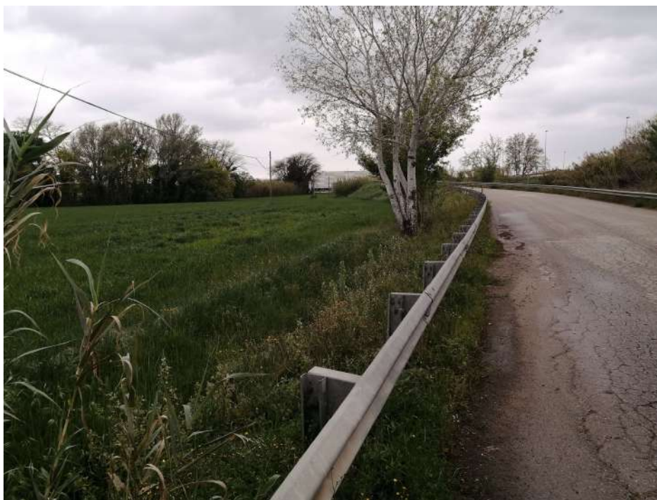
Punt de connexió amb la Carretera dels càmpings, on finalitza el Tram 1 i comença el Tram 2
