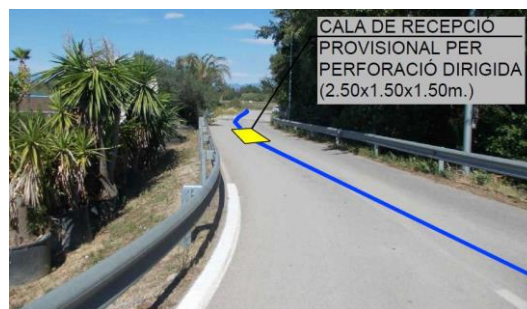
Cata de recepció de la perforació dirigida per l'encreuament de la C-260
