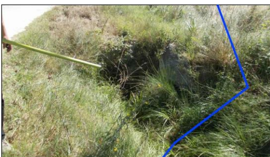
Encreuament canals de rec.
