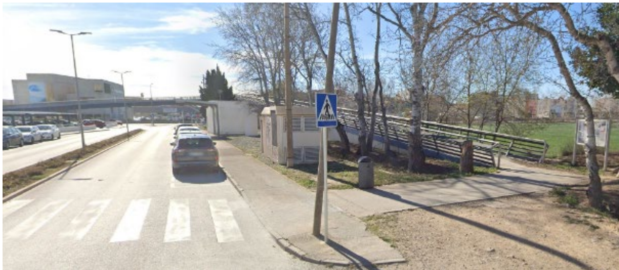
Vista de Nord a Sud. S'aprecia l'inici de la passarel·la, l'Estació Transformadora i el vial urbanitzat.
