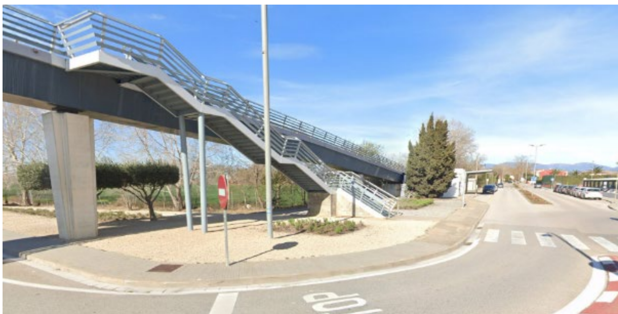
Vista de Sud a Nord. S'aprecien la passarel·la, l'edifici d'equipaments i el vial urbanitzat
