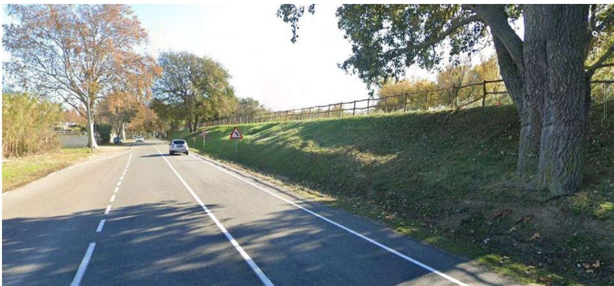
Cavalló de la riba esquerra de la Muga, de protecció front les avingudes estimades en el ARPSI.
