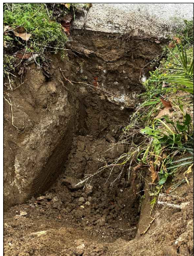
EXCAVACIO PER COMPROVAR LA FONAMENTACIO. ES COMPROVA QUE EL MUR NO TE FONAMENTS.
