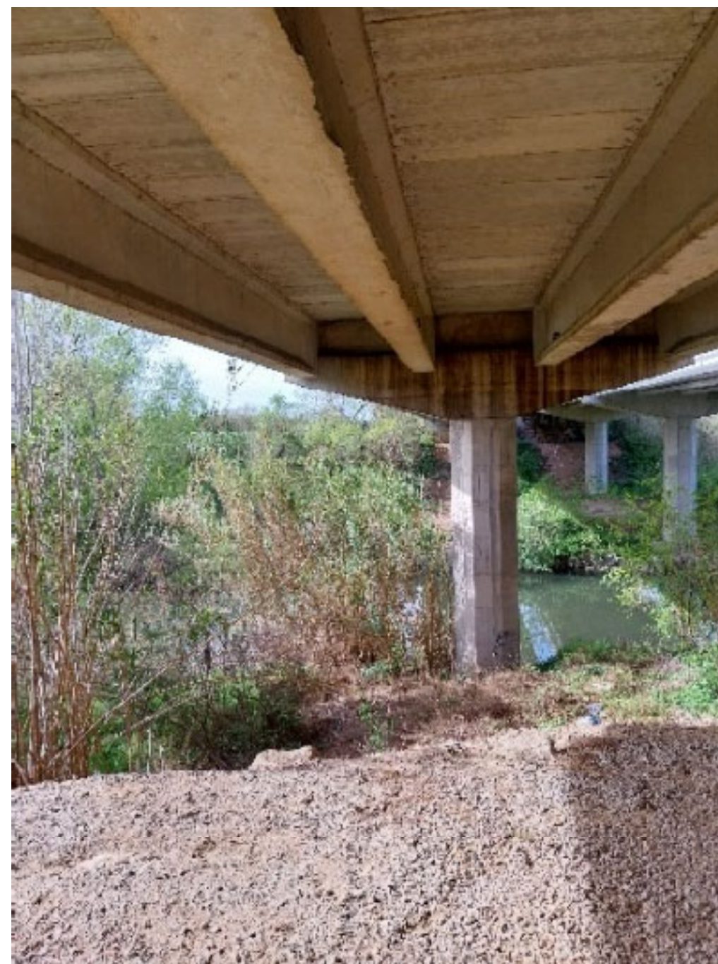
Figura 5. Vista part inferior i lateral pont carretera C-260
