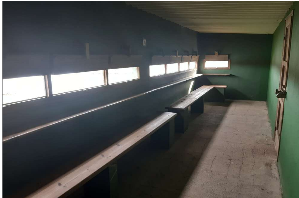
Figura 42. Els observatoris es pintaran de colors que es mimetitzin amb l'entorn i els tancaments seran de fusta. Per poder gaudir d'una millor visibilitat de la fauna de l'estany, es podran elevar fins a 1,8 m per damunt de la rasant i s'ocultaran amb vegetació en aquells costats on això sigui possible.
