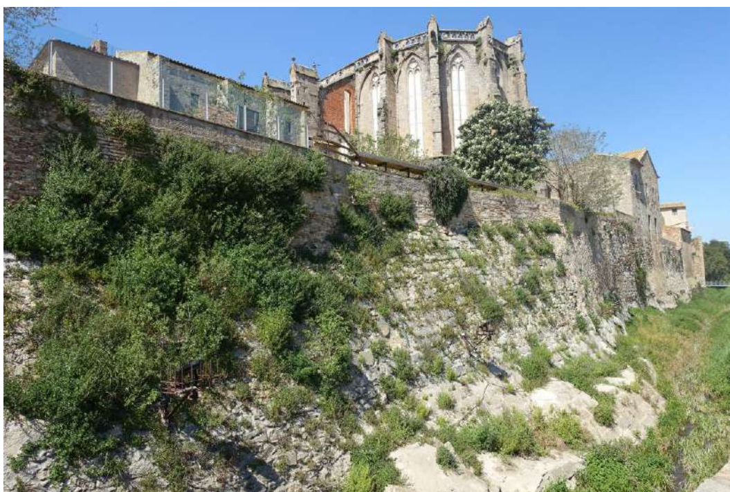
Tram 7 - Visió general de la vessant sud de la muralla.
