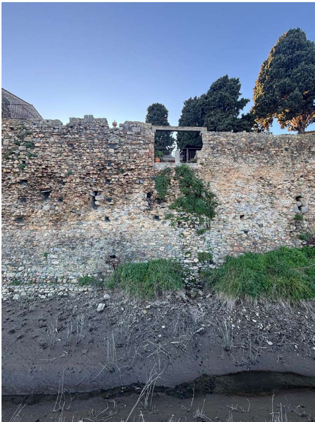
Imatges general del parament del tram de les espitlleres
