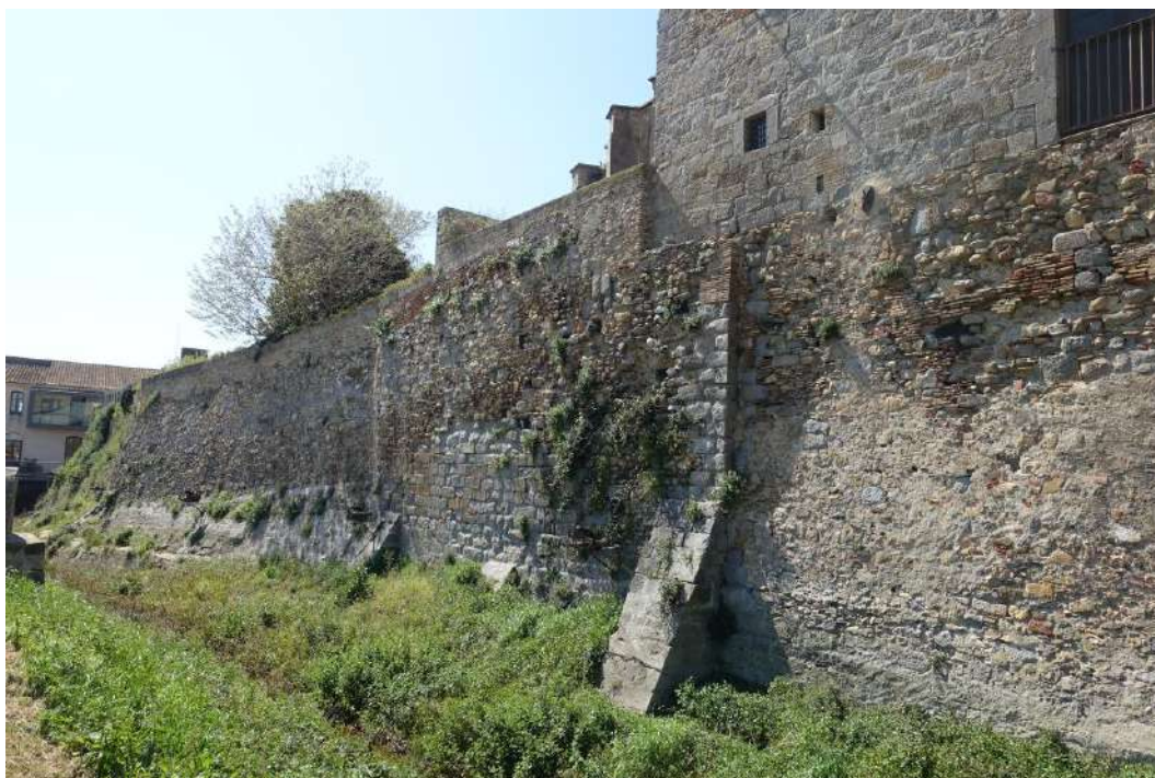
Trams 6 i 7 - Visió general del tram sud de la muralla.
