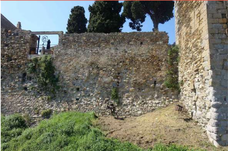
Imatge de detall del tram d'actuació
