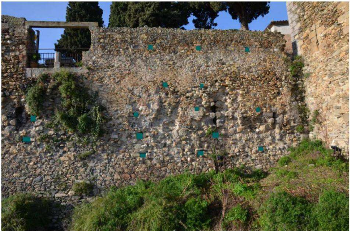
Fig. 8: Línies de forats de bastida en el tram nord
