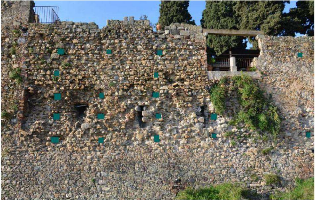
Fig. 7: Línies de forats de bastida en el tram sud
