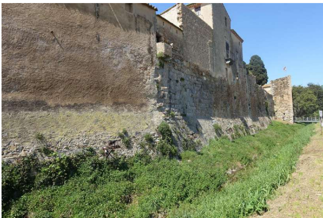
Tram 4 - Visió general de la muralla des de la vessant sud, amb el tram de les espitlleres (T3) i el Portal de la Gallarda al fons (T2).
