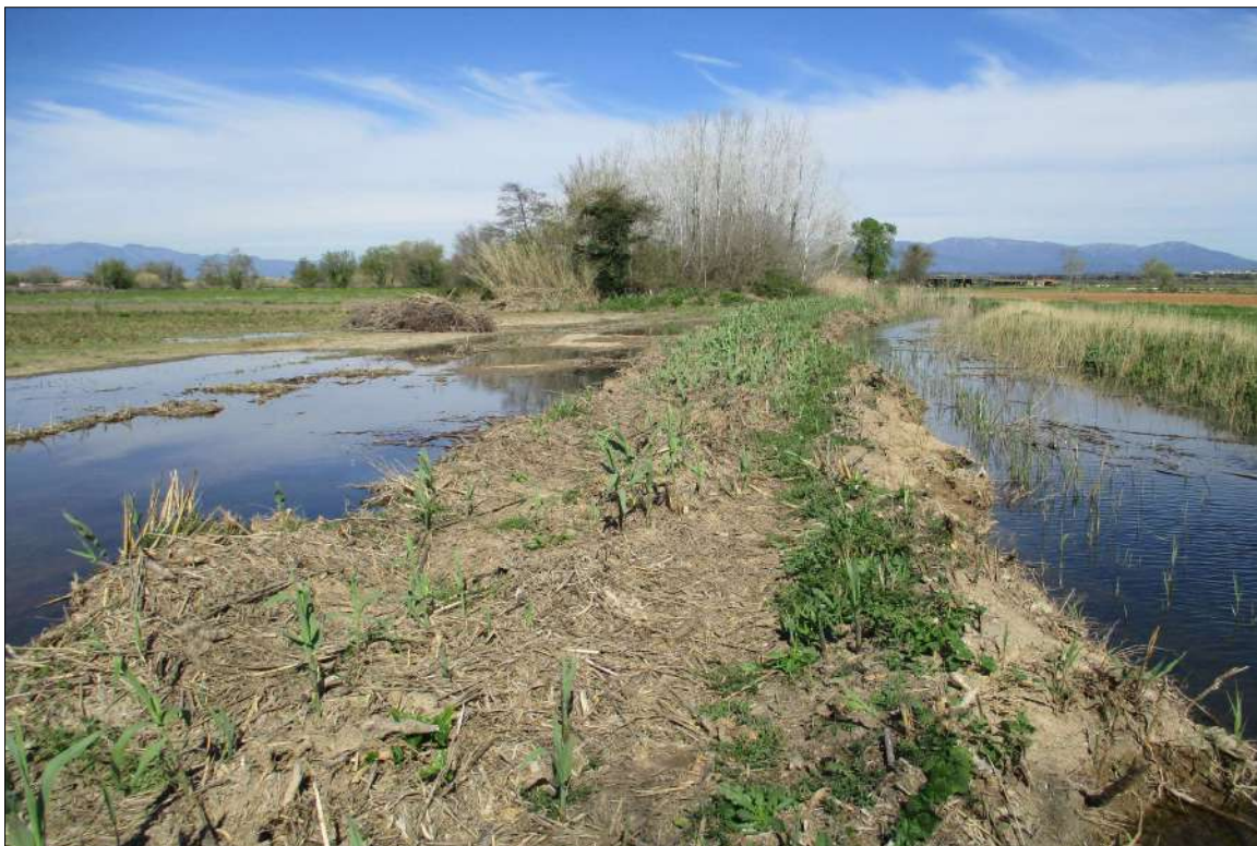
Imatge 5. L'acció erosiva de l'activitat agrícola o la mateixa debilitat estructural de les motes per causes diverses, comporta sovint episodis d'inundació dels conreus adjacents.
