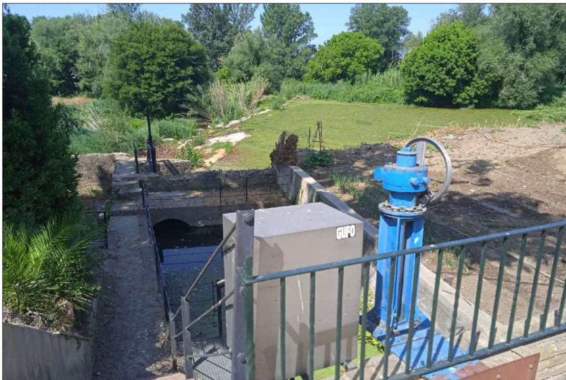
Imatge 6. Resclosa de Vilanova de la Muga, des d'on es deriva l'aigua cap al rec del Molí. Aquesta infraestructura presenta recurrents problemes de colmatació per sediments i de filtracions. En primer terme s'observa el mecanisme que obre i tanca la comporta regulant el cabal d'entrada al rec.
